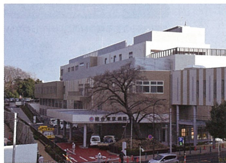
完成した総合東京病院の新棟
