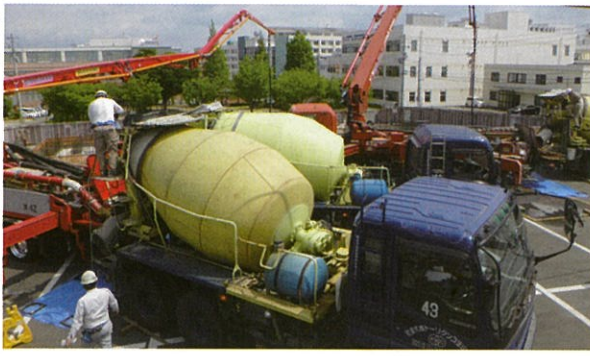
大型ポンプ車を使って行われた1階床のコンクリート打設工事 5月31日
