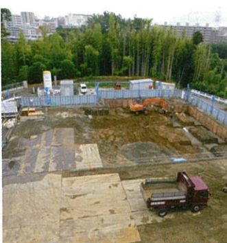
新棟建設に伴い始まった立体駐車場の建設工事
